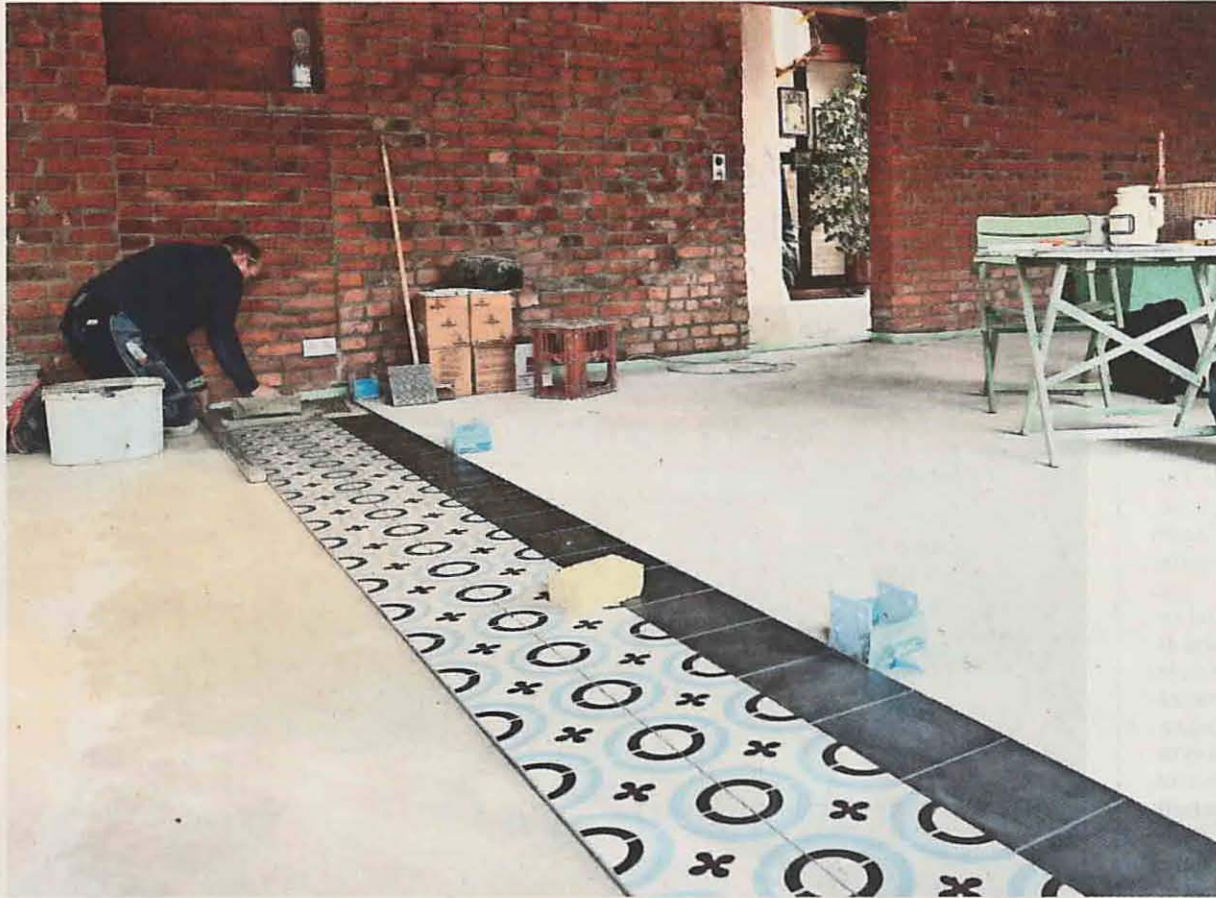
▲ Im Gastraum verlegen Handwerker die neuen Bodenfliesen.
